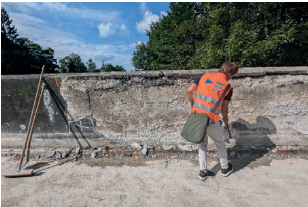
Abb. 10: Verputz und Fahrbahnbelag entfernt
