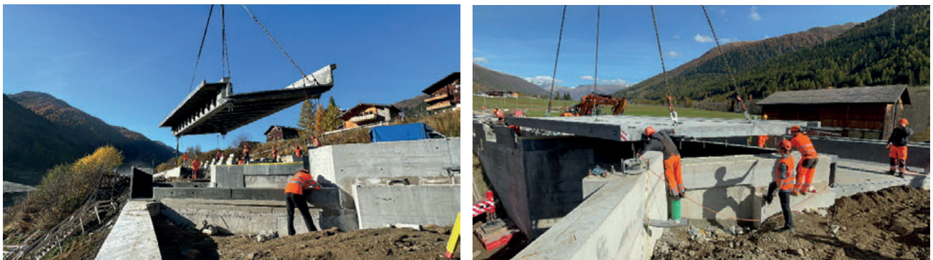
Abb. 9: Montage von Bahnbrücke (links) und Perronbrücke (rechts)
