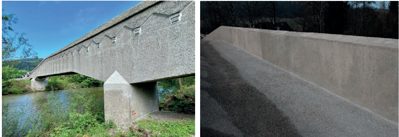
Abb. 21: Ansicht des Verputzes auf den Aussen- und Innenseiten nach der Restaurierung
