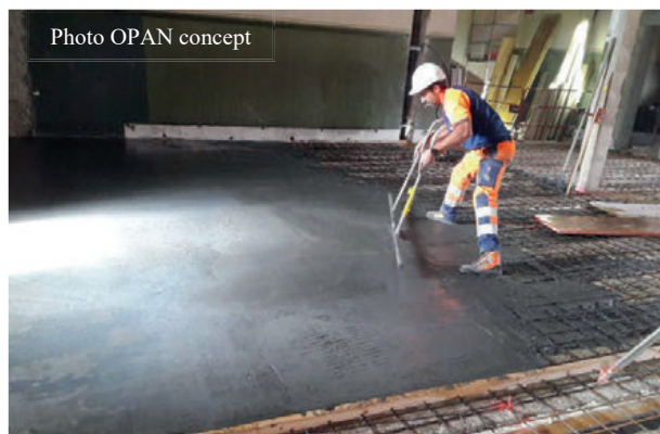
Fig. 13 : Mise en œuvre du CFUP
