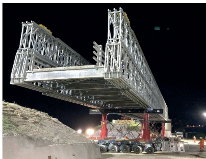
Fig. 19 : OCP de nuit - Dépose du pont provisoire
