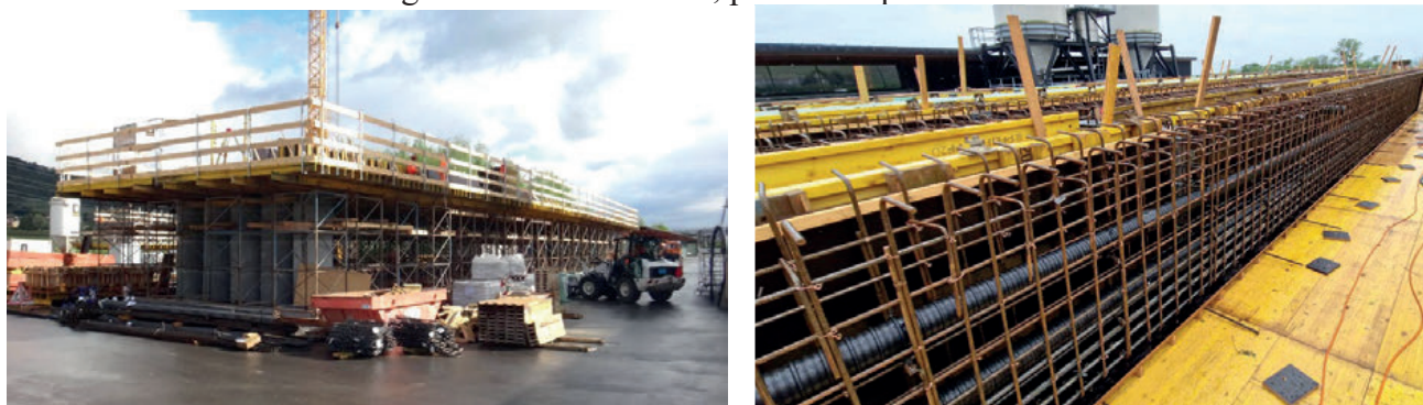
Fig. 17 : Cintre et coffrage du tablier; armature
