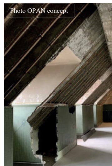
Fig. 3 : Principe statique des cadres du 4 ème étage (à gauche) et photo du montant Sud des cadres (à droite)
