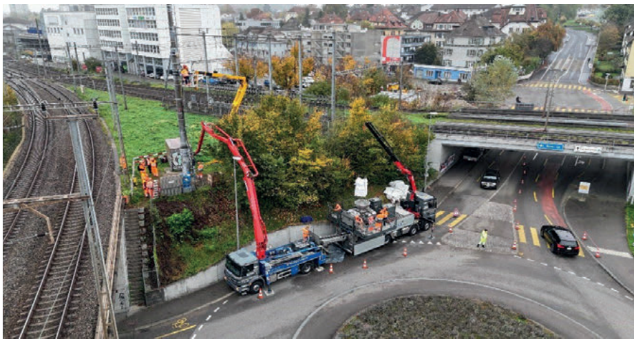
Abb. 9: Verstärkung Pilotprojekt mit dem MR-HT-SYSTEM ® , Baustelleneinrichtung (links) und Pumpvorrichtung bzw. Einfüllstutzen am Masten (rechts)
