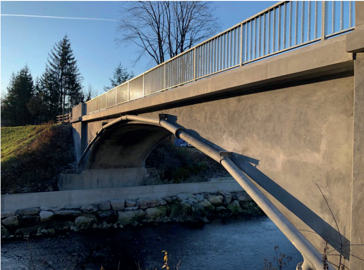
Fig. 6 : Vue du pont après remise en état
