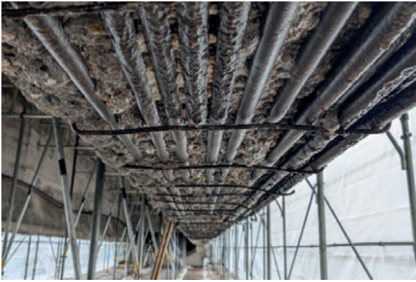
Abb. 16: Der freigelegte Untergurt
