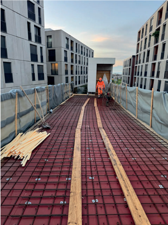
Fig. 6 : Tôle de platelage juste avant application du CFUP avec l'armature en place
