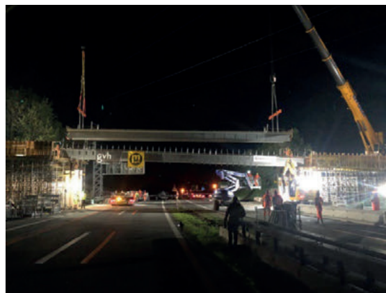
Fig. 10 : Emplacement prêt pour la pose ; Pose de la seconde poutre de 72 t
