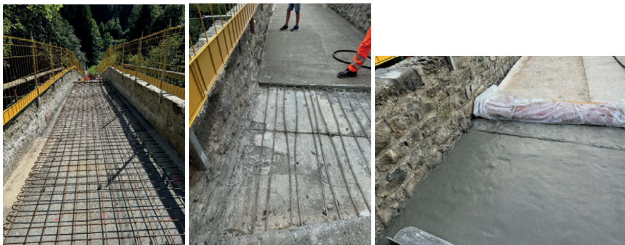
Fig. 6 : Armature de treillis dans la dalle en béton (à gauche) ; dalle en béton réalisée et armature en attente pour le CFUP armé sur les clefs de voûtes, le décrochement correspond à la surépaisseur de CFUP au droit de la clef (Fig. 5) (au milieu) ; aspect de la couche de CFUP de 40 mm, fraîchement posée
