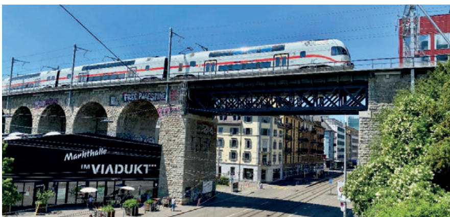
Abb. 1: Teilansicht des Wipkingerviadukts nach dem «Upcycling» (Foto E. Brühwiler, 15. Mai 2025)
