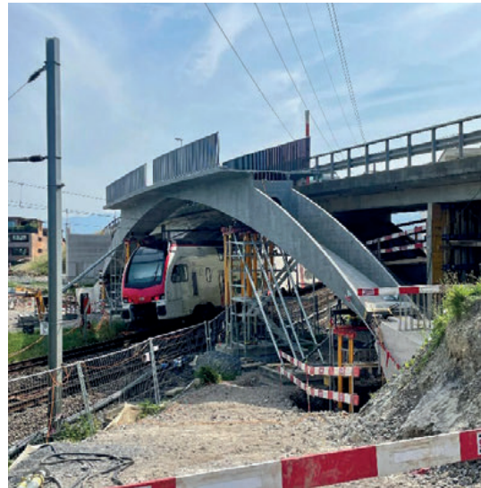
Abb. 22: Bogenelemente auf Hilfsabstützungen
