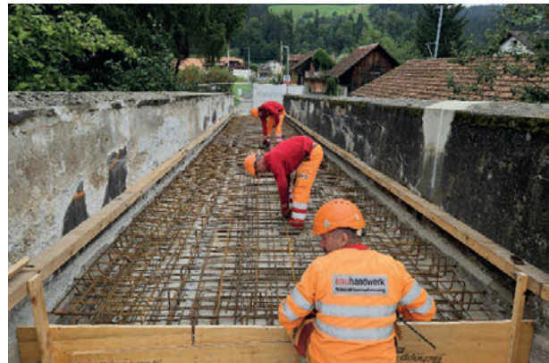
Abb. 11: Bewehren der Betonplatte im Randfeld
