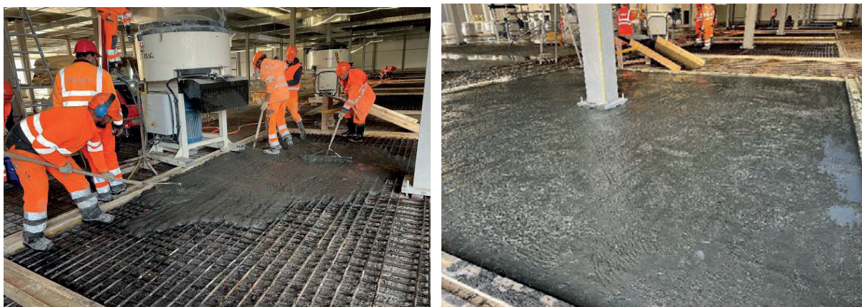
Fig. 10 : Mise en place du CFUP à l'aide de râdeaux (gauche) ; bétonnage d'une étape terminée avant protection (droite)
