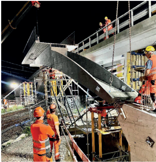
Abb. 21: Bogenelement am Kran
