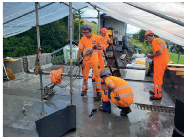
Abb. 33: Fugenverguss mit Regenschutzdach
