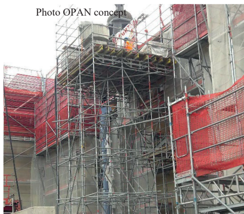
Fig. 12 : Le malaxeur a été mis en place sur une plateforme située au niveau de réalisation afin de limiter la manutention du CFUP frais
