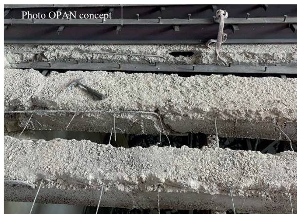
Fig. 11 : Déconstruction partielle de la table de compression, puis mise en place des profilés métalliques
