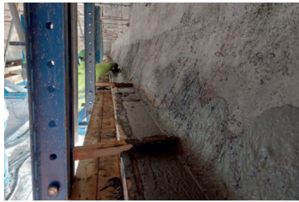
Abb. 17: Der geschalte und mit UHFB vergossene Untergurt
