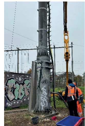
Abb. 9: Verstärkung Pilotprojekt mit dem MR-HT-SYSTEM ® , Baustelleneinrichtung (links) und Pumpvorrichtung bzw. Einfüllstutzen am Masten (rechts)
