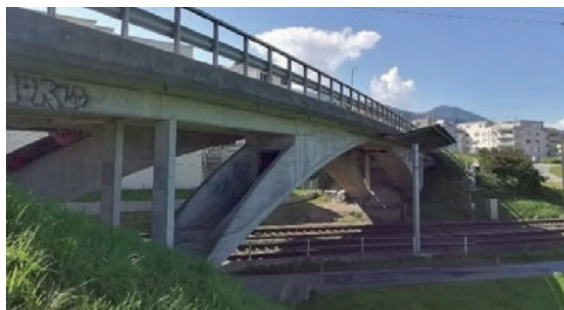
Abb. 4: Maillart-Brücke. Westlicher, seeseitiger Dreigelenkbogen, Foto 11.09.2021
