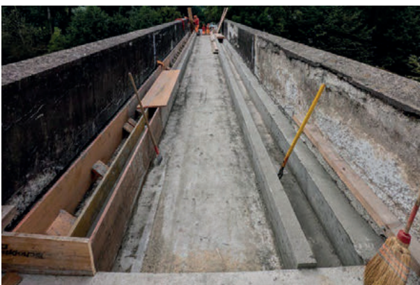
Abb. 12: Betonriegel im Mittelfeld
