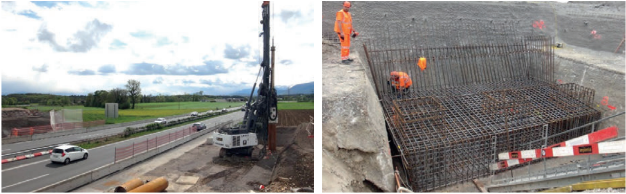
Fig. 20 : Travaux sur fondations et culées
