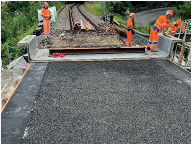
Abb. 30: UHFB-Element auf Splittplanum und Elastomerstreifen über Mauerwerk am Rand
