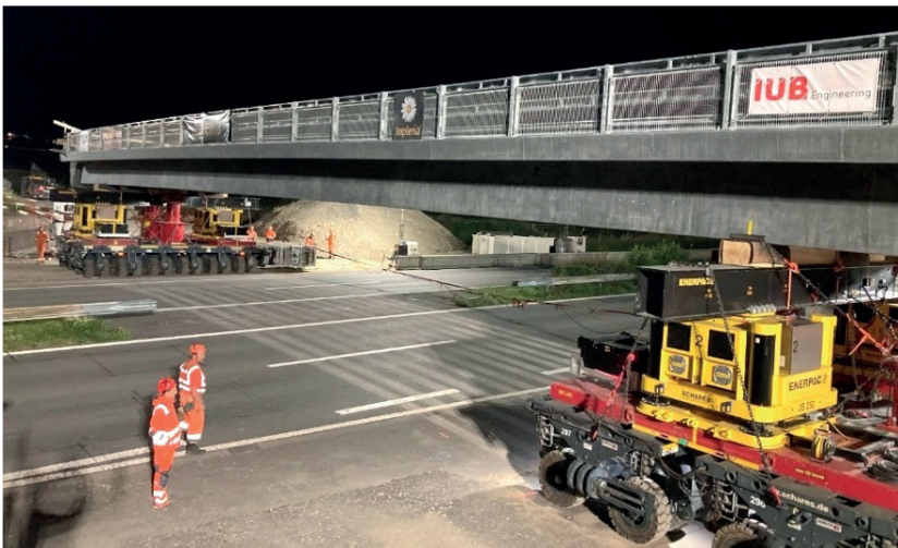
Fig. 22 : Déplacement du tablier pré-bétonné par chariot SPMT
