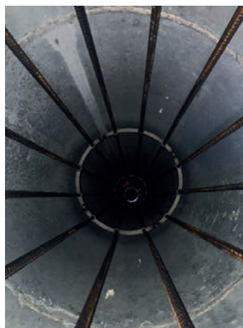
Abb. 10: Bewehrungslayout: Verankerungsbewehrung auf bestehendem Fundament (links), Bewehrung im Stahlrohr (mitte) und Bewehrung an einem Rohrstoss (rechts)
