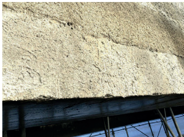
Abb. 20: Verputzarbeiten: Innenseite des Hauptträgers (links) und erste Verputzlage auf dem UHFB des Untergurts im Mittelfeld
