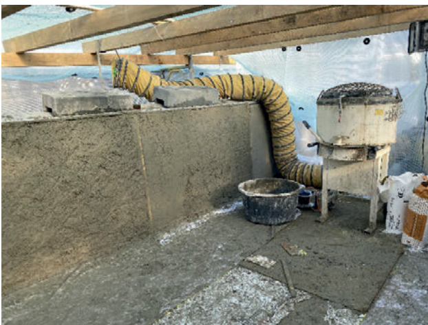
Abb. 20: Verputzarbeiten: Innenseite des Hauptträgers (links) und erste Verputzlage auf dem UHFB des Untergurts im Mittelfeld
