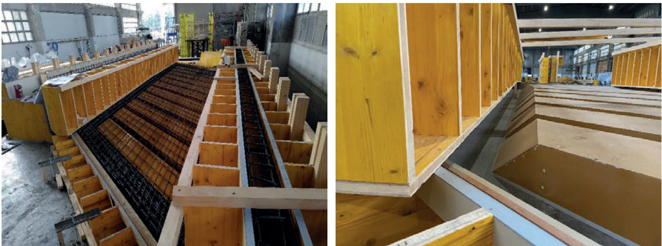
Abb. 7: Schalung und Bewehrung der Bahnbrücke
