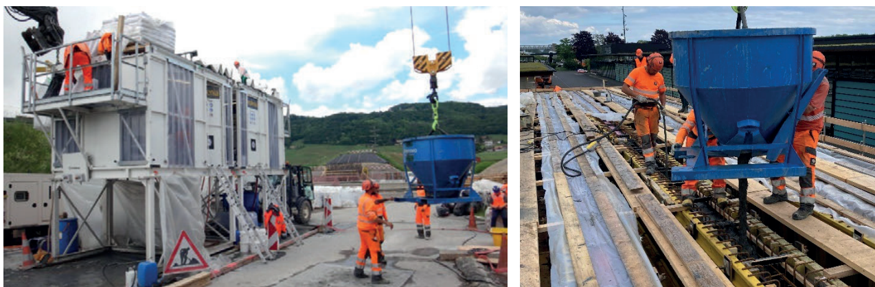
Fig. 13 : Stations de production du CFUP – Implen SA
