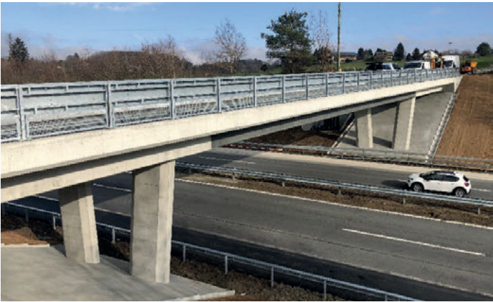
Fig. 1 : Nouveau passage supérieur de Chenaule
