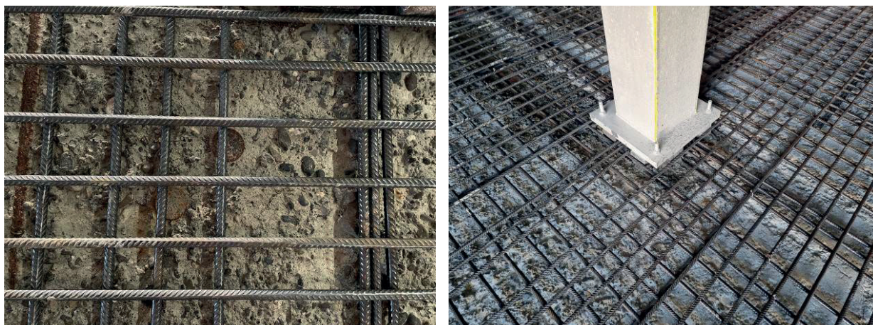
Fig. 8 : Hydrodémolition de la surface sur une profondeur d'environ 1 centimètre
