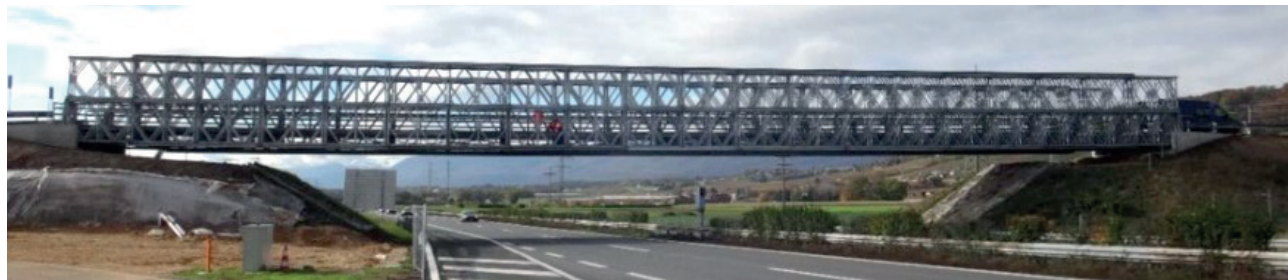
Fig. 2 : Pont provisoire – Type Bailey, portée statique l=60m – Poids propre 250to
