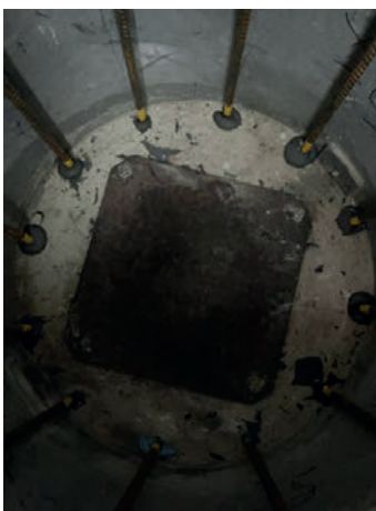
Abb. 10: Bewehrungslayout: Verankerungsbewehrung auf bestehendem Fundament (links), Bewehrung im Stahlrohr (mitte) und Bewehrung an einem Rohrstoss (rechts)
