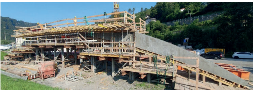
Abb. 20: Vorfabrikation in Ilanz
