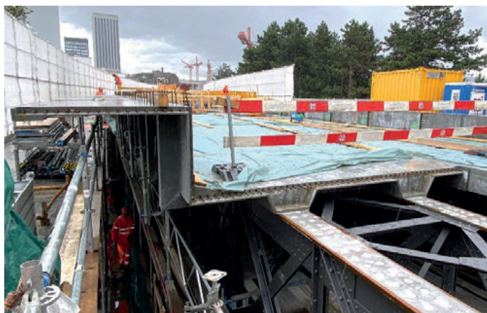
Abb. 5: Die gespiegelt identischen Stahl-UHFB-Trogelemente wurden auf den parallel angeordneten Zwillings-Stahlbrücken positioniert und mit der neuen Obergurtlamelle verschweisst. Der Quertfugen wurden mit UHFB kraftschlüssig verschlossen. (Fotos: E. Brühwiler. 30.05. und 03.07.2024)
