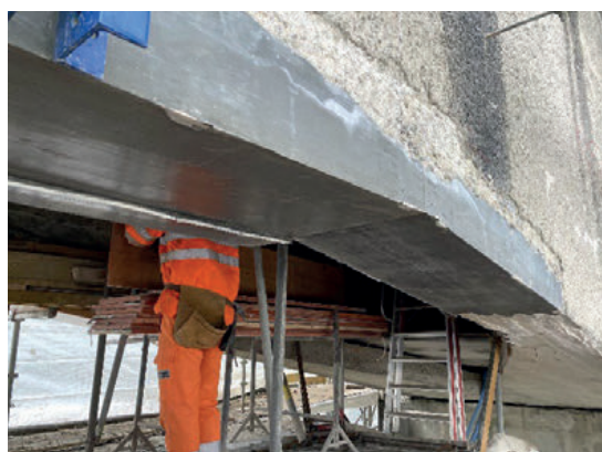
Abb. 19: Verankerung des UHFB-Zuggurts in der
