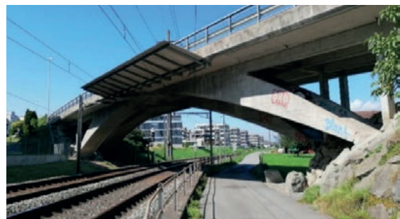
Abb. 5: Maillart-Brücke. Östlicher Dreigelenkbogen, Foto vom 11.09.2021
