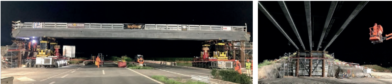
Fig. 21 : Mise en place du tablier – OCP de nuit
