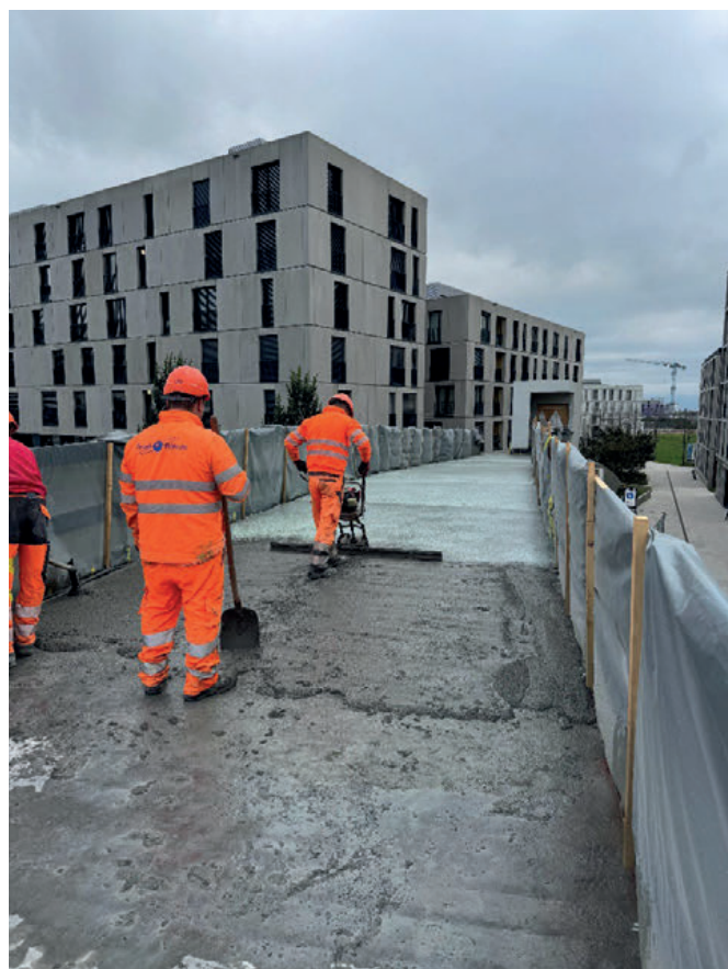
Fig. 9 : Mise en œuvre de la couche de revêtement matrice CFUP avec gravillons par l'entreprise Frutiger
