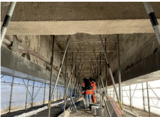
Abb. 18: UHFB Zuggurt-Verstärkung Druckzone des Untergurts nahe dem Pfeiler
