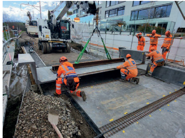
Abb. 31: Versetzen der Elemente mit Gleisbagger
