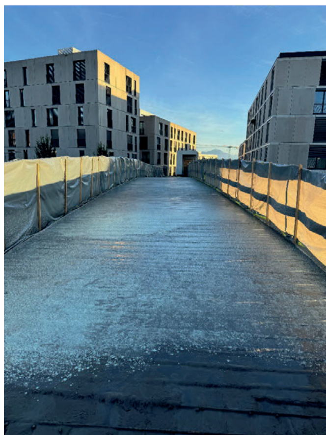
Fig. 8 : Application du produit de cure / retardateur de prise (de couleur vert/bleu) de la couche UB par l'entreprise Frutiger
