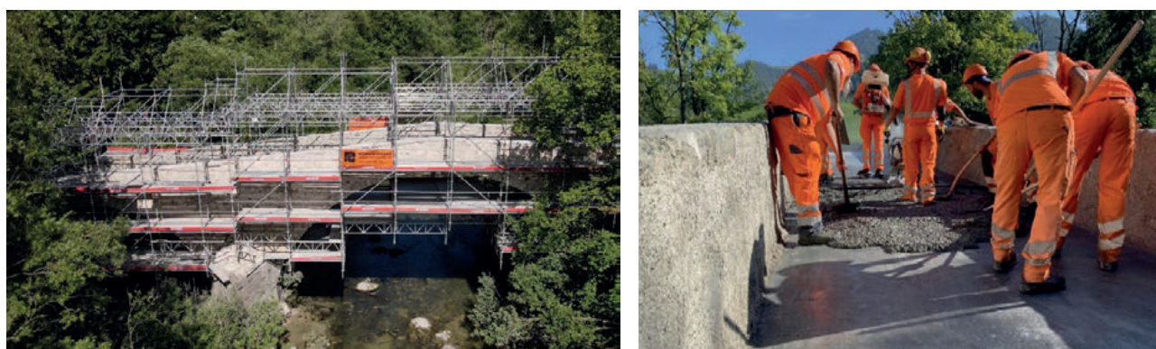
Fig. 4 : Vue de l'échafaudage suspendu, et place exiguë pour les travaux CFUP
