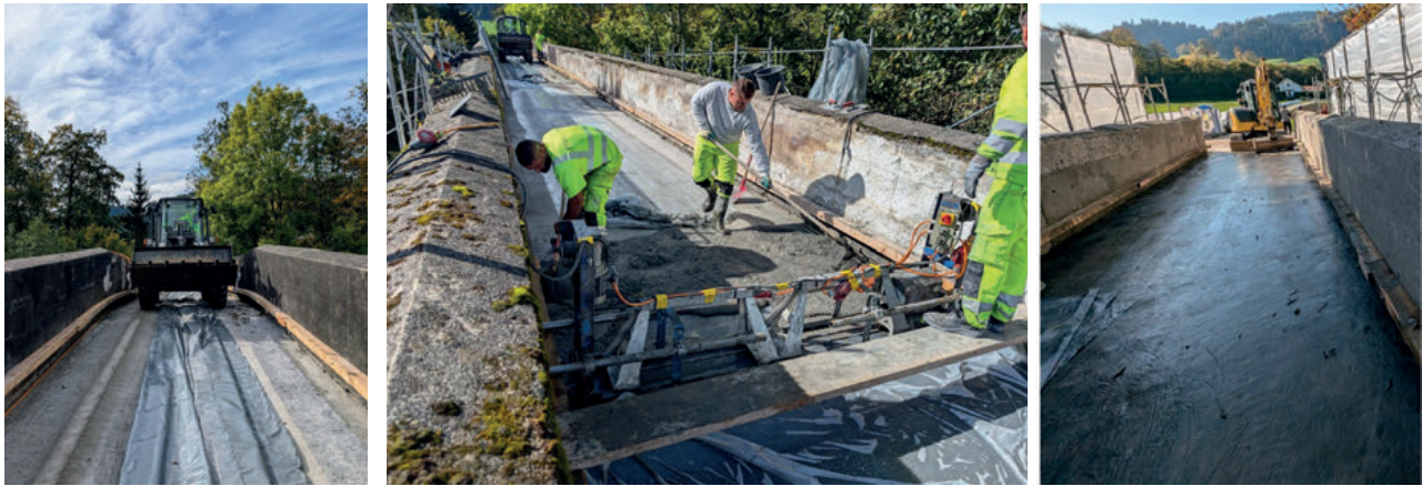
Abb. 13: Einbau der UHFB-Platte: Anlieferung Frisch-UHFB, Einbau mit Rüttelbohle, Ansicht nach Nachbehandlung
