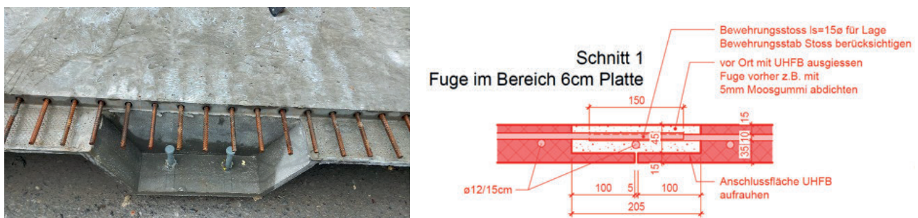
Abb. 4: Querfuge zwischen zwei Trogelementen
