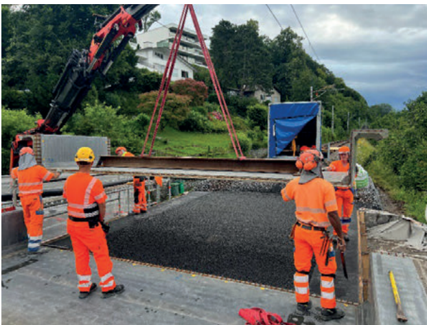
Abb. 32: Versetzen Elemente mit LKW-Kran
