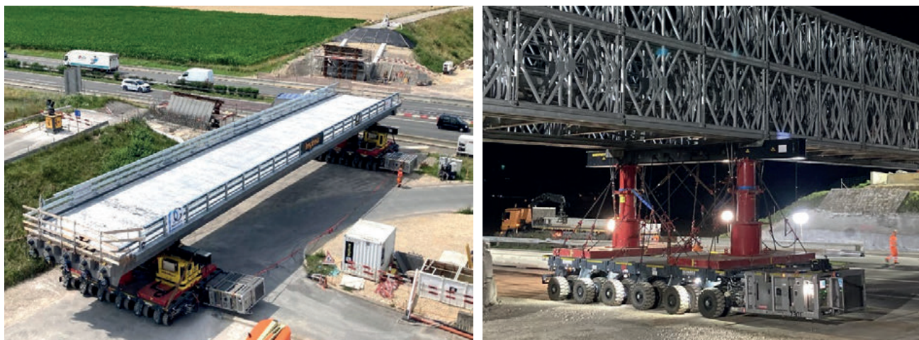
Fig. 5 : Logistique de chantier – chariots SPMT
