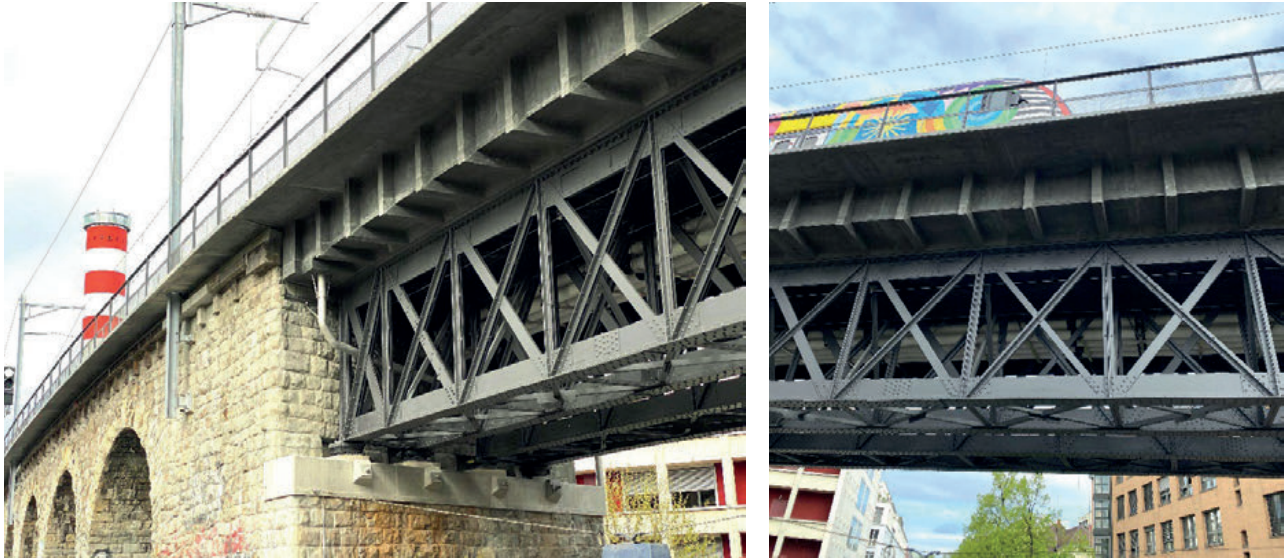
Abb. 6: Der UHFB-Schottertrug auf den genieteten Stahlträgern nimmt die filigrane Formensprache der ursprünglichen Stahlbrücken und Mauerwerkkrone auf und schreibt sie weiter. Die auskragende UHFB-Platte vereint die leichten, genieteten Stahl – UHFB Brücken mit dem massiven, jedoch filigran gestalteten Natursteinviadukt. (Fotos: E. Brühwiler, 16.04.2025)
