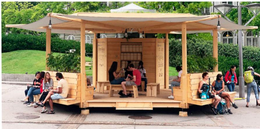
Mit dem Klimapavillon soll die Wirksamkeit einer dem Klimawandel angepassten Freilächeneinrichtung aufgezeigt werden. Hierzu wurden verschiedene einfache Massnahmen gebündelt umgesetzt, unter anderem die Dach- und Fassadenbegrünung, Phasenwechselmaterialien, Wasserflüsse und Sprühnebel, die Optimierung der Beschattung sowie poröse Keramikgefässe für die Abgabe von Wasserdampf.
