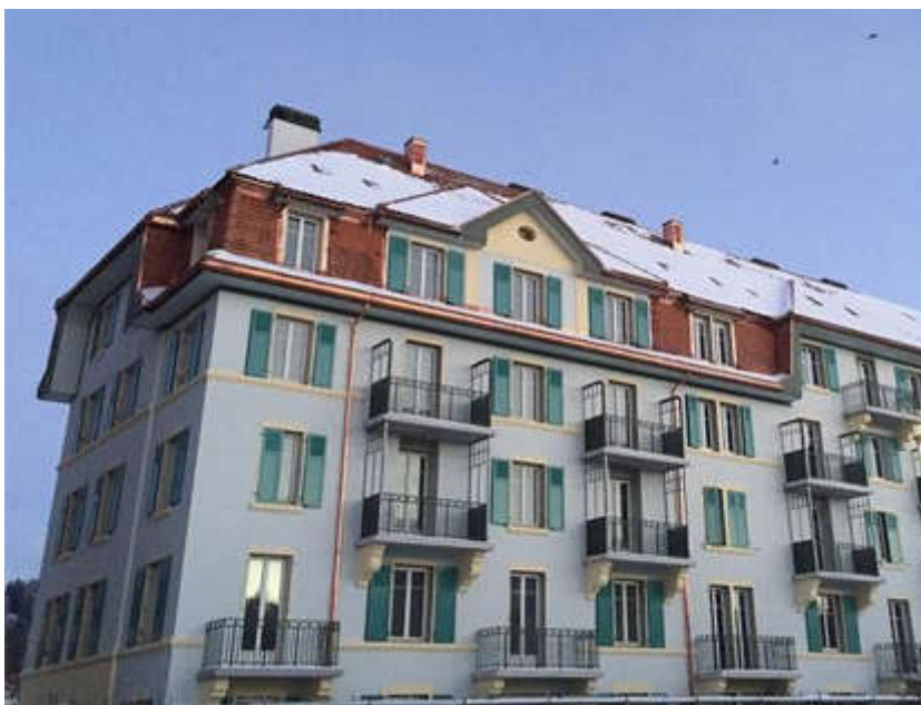
L'immeuble La Renouveau, construit en 1914, a retrouvé tout son éclat après sa rénovation à La Chaux-de-Fonds.
