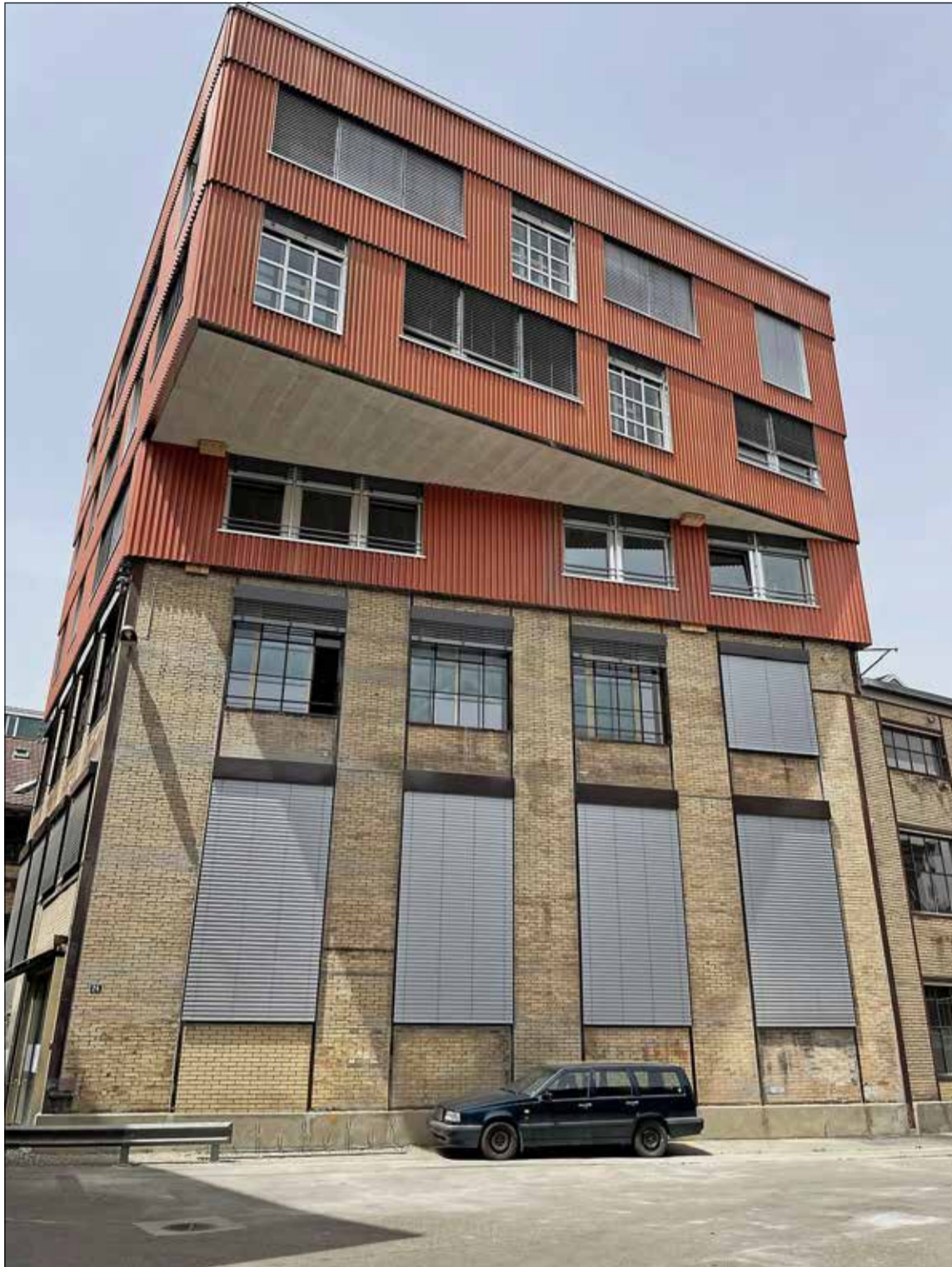
A Winterthour, In Situ a surélevé une ancienne usine avec 80% d'éléments de récupération. CHARLES GRANDJEAN - LA LIBERTÉ
