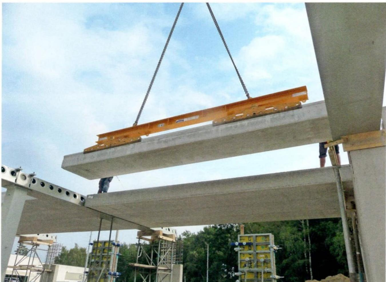
Bei der Wiederverwendung werden ganze Bauteile, wie beispielsweise Stahlträger oder Teile von Betonwänden, aus bestehenden Gebäuden ausgebaut und unverändert als Komponenten für einen Neubau wiederverwendet.
