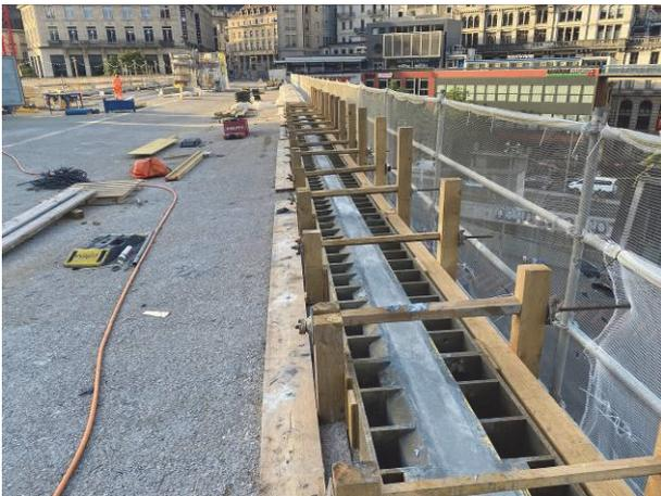
Fig. 9 Vue du bétonnage de la bordure CFUP (photo INGPFI 2022)
