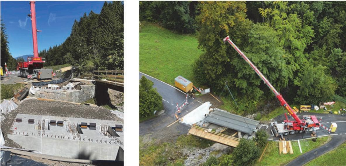
Fig. 10 : Pose à la grue des fondations et du tablier
