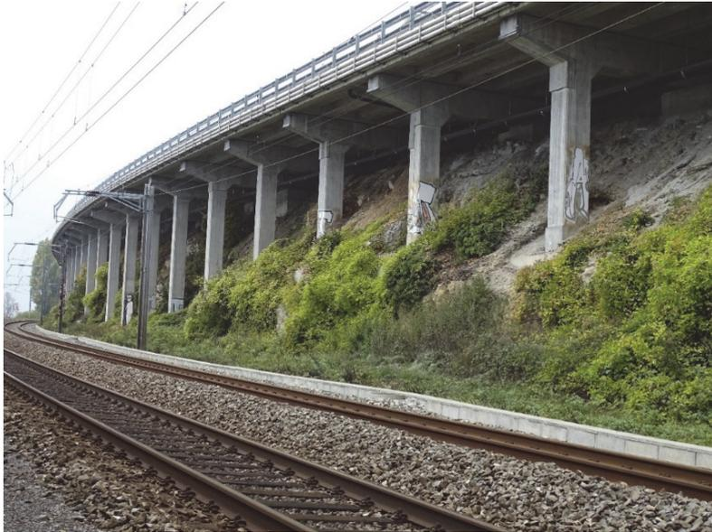
L'ouvrage présente des problèmes d'étanchéité au niveau des joints, de façon similaire aux ponts NB 72 : l'eau qui s'y infiltre coule le long des cadres et de certaines piles et provoque des dégâts sur la structure. Des traces d'humidité, noircissement du béton et tâches de corrosion locales sont constatés lors d'inspections visuelles. Une intervention a déjà eu lieu au préalable, dans les années 90, avec la mise en place très locale de béton projeté.
