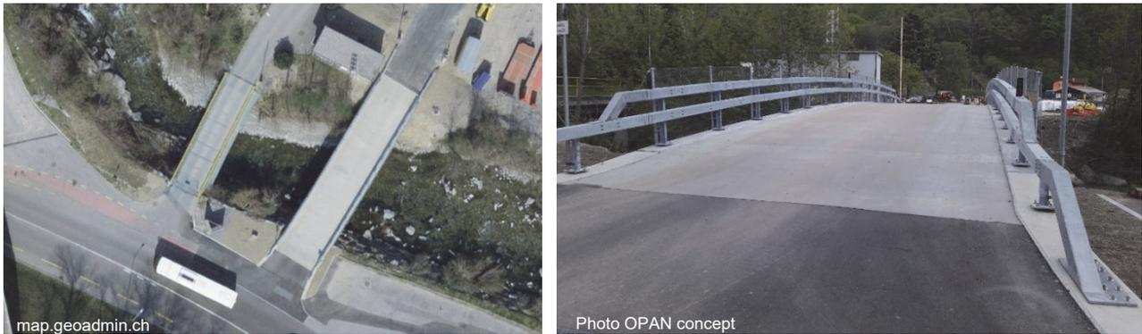
Fig. 17 : Vue aérienne de l'ancien pont à déconstruire et du nouveau pont en CFUP (photo de gauche) et vue de la surface de roulement en CFUP
