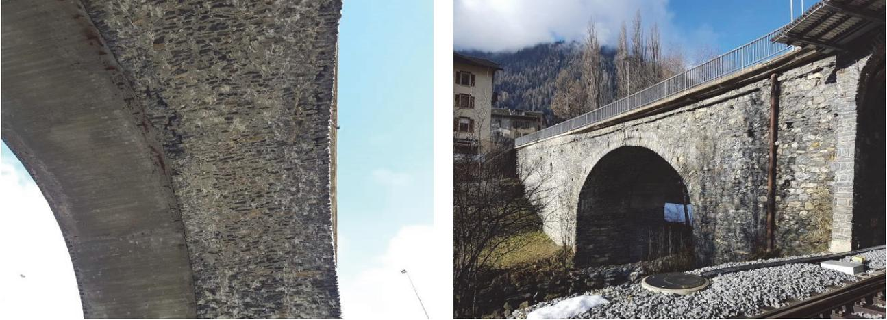
Fig. 4 : Etat de la maçonnerie de pierre
