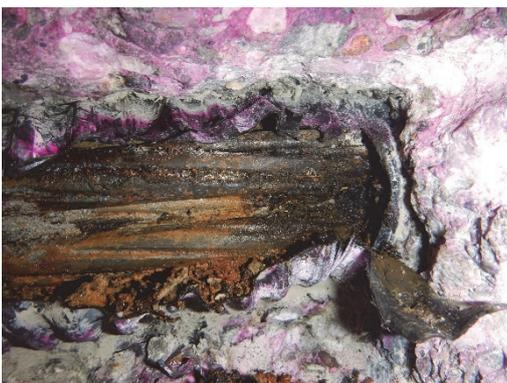
Fig. 6 : Vue des torons corrodés à l'intérieur d'une gaine de précontrainte ouverte dans le cadre des investigations
