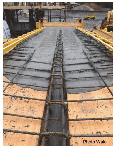
Fig. 12 : Coulage du CFUP et détail du ferrailage
