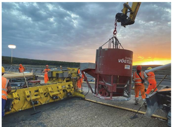
Abb. 1: Pont d'Ouche, UHFB-Einbau
