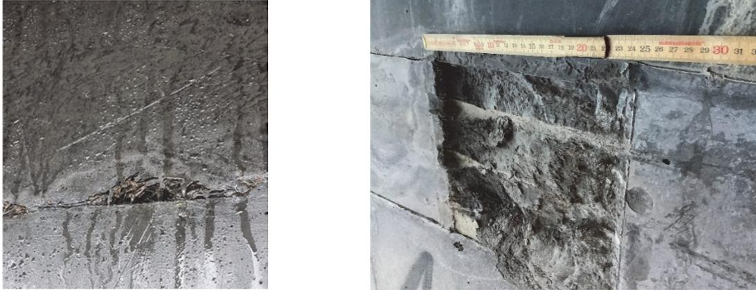
*Fig. 5 : Exemples de défauts d'exécution: niches des fibres à gauche ; surface après enlèvement de la goulotte de bétonnage à droite*
