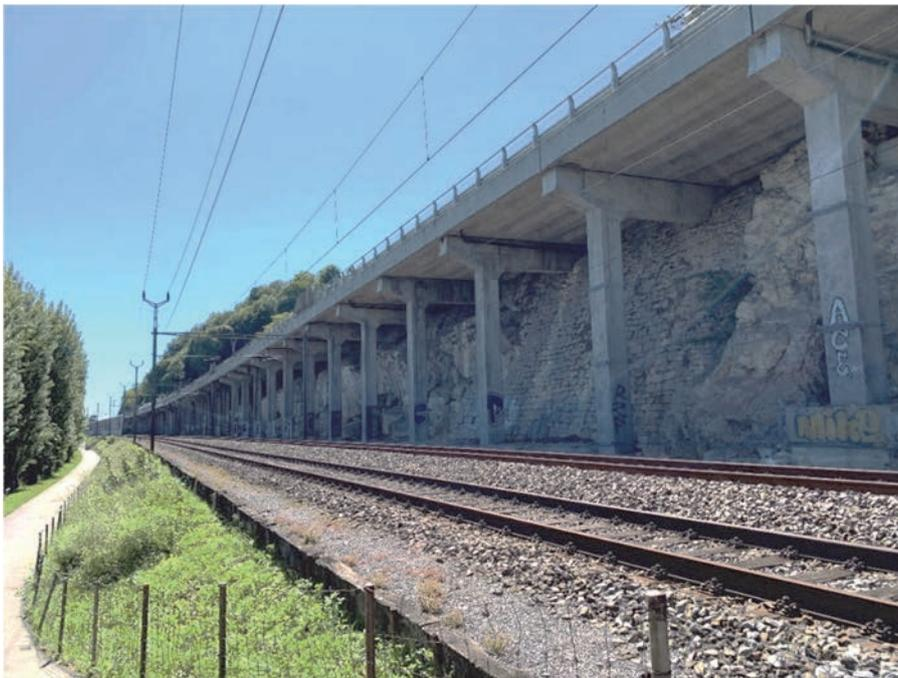
L'ensemble des 48 joints de chaussée du pont présente des problèmes d'étanchéité. Les infiltrations d'eau sur l'intrados sont responsables d'une dégradation des entretoises et des têtes de piles des cadres. Les dégâts principaux relevés visuellement lors des inspections sont les suivants : traces d'humidité sur la majorité des entretoises, noircissement du béton, tâches de corrosion locales, éclatement local du béton avec armature corrodée apparente.
