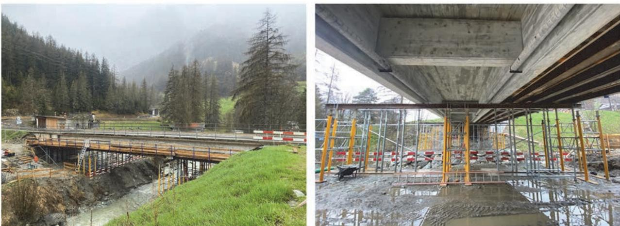
Fig. 10 : Installation de chantier et échafaudage pour soutenir le coffrage du porte-à-faux (Photos du 1<sup>er</sup> mai 2023)
