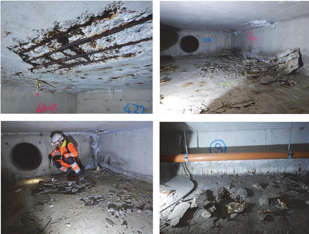
Fig. 5 : Vues des dégâts à l'intérieur du caisson
