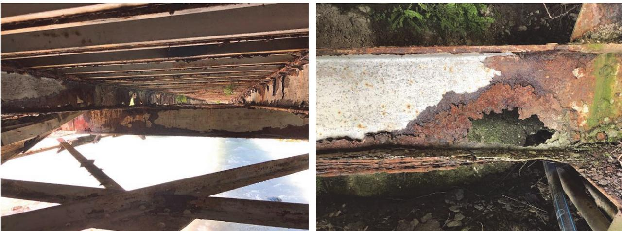
Abb. 3: a) Untersicht der Brücke, b) Querschnittsverlust beim Endquerträger
