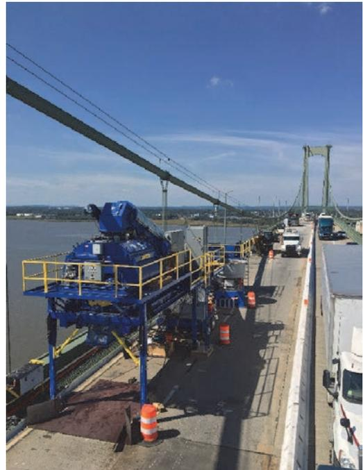
Abb. 8: Mischanlage auf der Brücke
