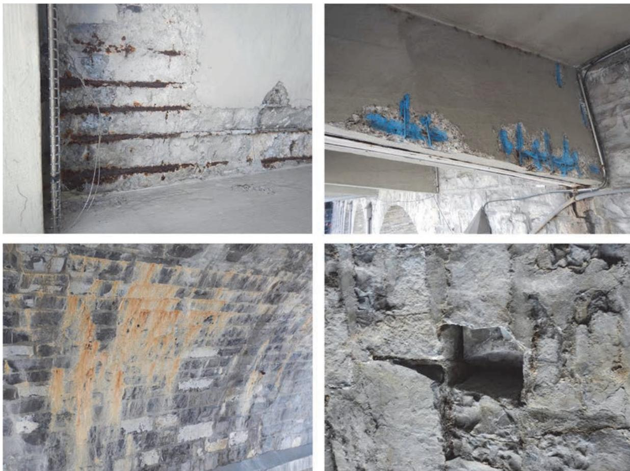
Fig. 4 Dégâts types observés sur les encorbellements en béton (haut) et les maçonneries (bas) (photos INGPHI 2020)
