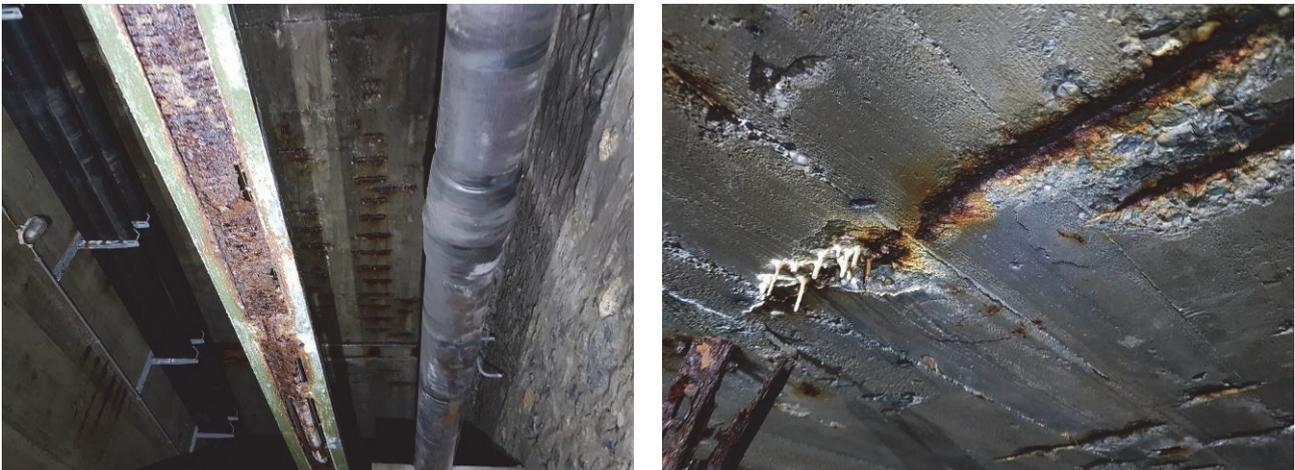
Fig. 5 : Etat de la face inférieure du tablier
