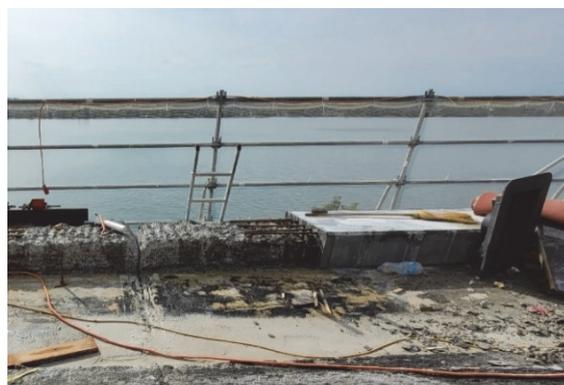
Fig. 10 : Bordure de l'ouvrage NB 74 : Préparation du support et joint de reprise
