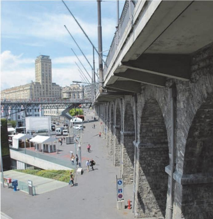
Fig. 3 : Elargissement du Grand-Pont de 1933 avec des encorbellements en béton (photo INGPHI 2017)
