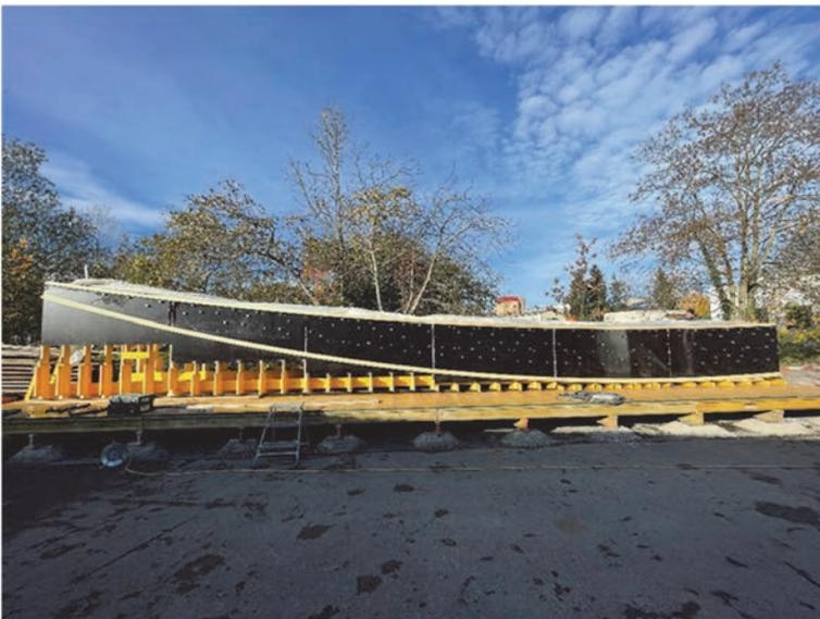
Fig. 8 : Vue partielle du coffrage
