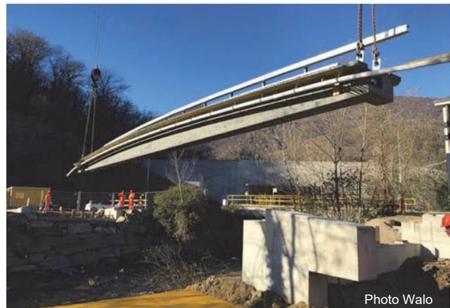
Fig. 14 : Levage et mise en place d'une poutre de bord. Celle-ci est munie de sa bordure, du dispositif de retenue et de toutes les conduites de tiers
