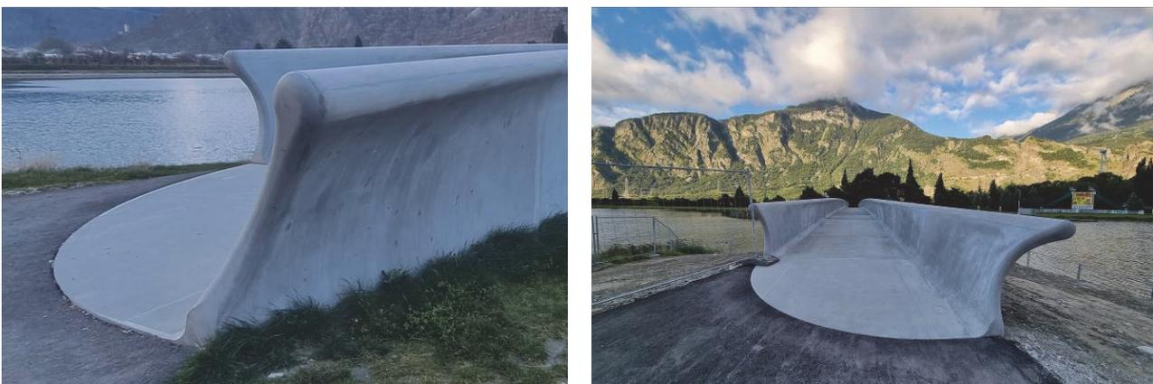
Fig. 4 : Détails architecturaux : extrémité des parapets et matrice anti-glisserment
