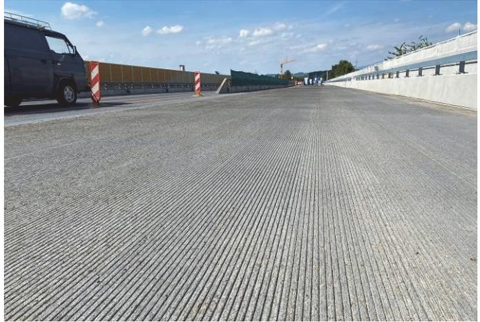
Abb. 6: Oberfläche mit Rillen
