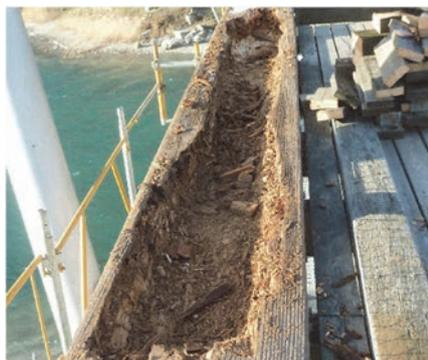
Fig. 2 : Illustration de l'état de la membrure supérieure. Photo du SDM
