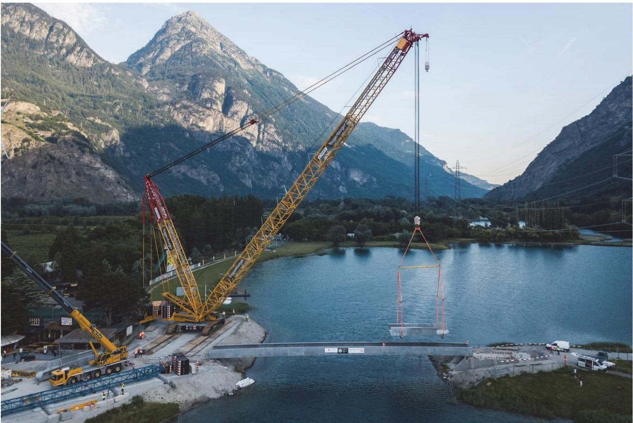
*Fig. 11 : Assemblage, mise en tension de la précontrainte, mise en place de la passerelle*
