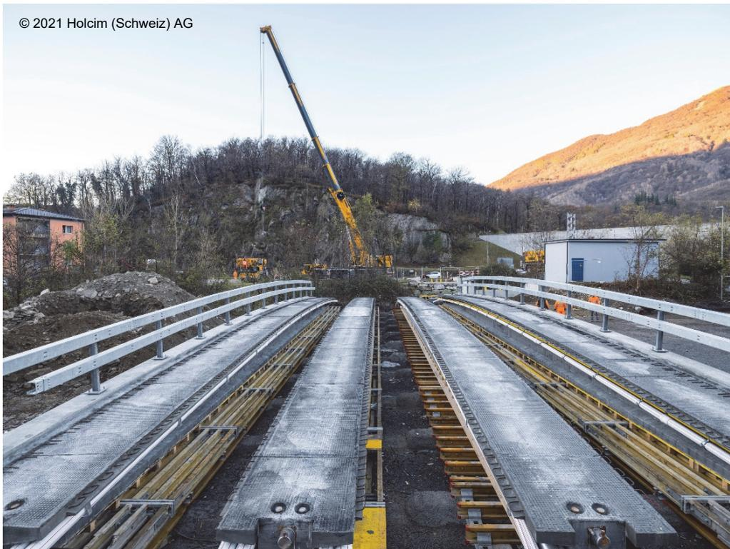
Fig. 13 : Poutres préfabriquées sur le banc de fabrication, avant leur mise en place
