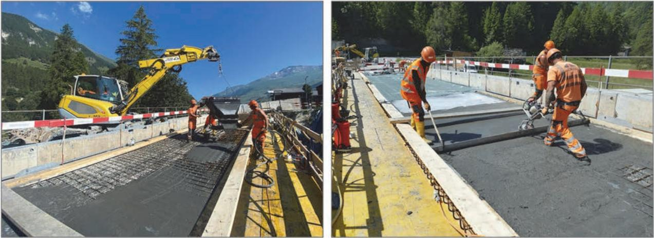
*Fig. 11 CFUPage du porte-à-faux et de la couche sur le tablier dans la partie amont de l'ouvrage (Photos du 1<sup>er</sup> juillet 2023)*
