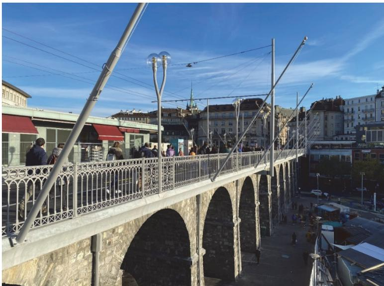
Fig. 10 Vue en enfilade du garde-corps et de la bordure en CFUP (photo INGPHI, 2023)
