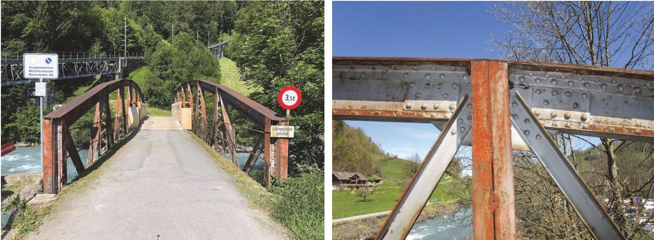
Abb. 2: a) Ausgangszustand des Brückentragwerks mit mittiger Holzkonstruktion zur Überbrückung der durchgebrochenen Belagsflächen, b) Knotendetail des Fachwerkträgers
