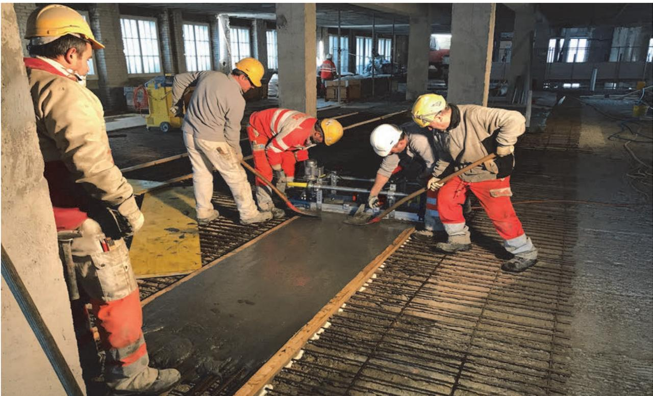
Abb. 9: Einbau des UHFB
