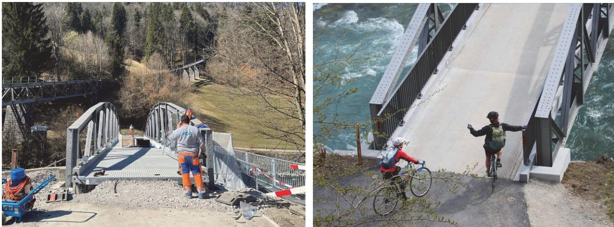
Abb. 10: a) Gegenseitige Vorspannung der Fertigelemente, b) Brückenenddetail mit über die Widerlagerwand hinausragender Fahrbahnplatte (Quelle N. Matschoss)
