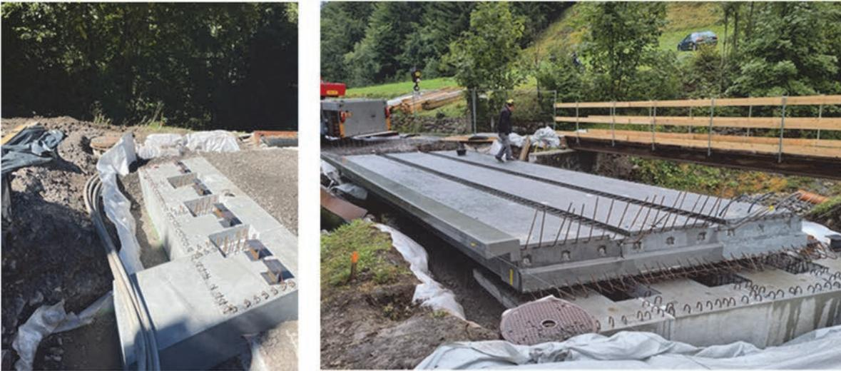
Fig. 6 : À gauche : fondations en béton armé avec élément de bord amont plus long, à droite : éléments du tablier avec armatures en attente
