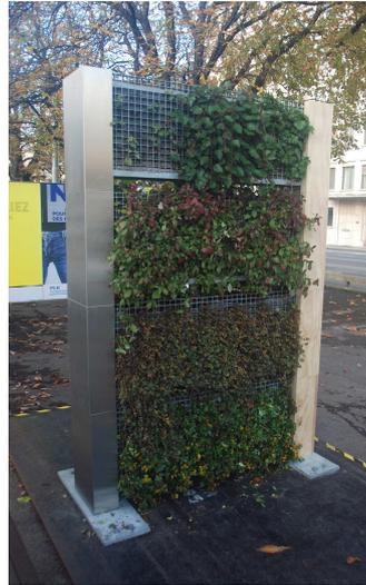
Figure 1 : Prototype d'une structure filtrante du projet SMACC composé d'un panneau en métal et d'un panneau en bois installée pour le bien de l'étude sur la plaine de Plainpalais.
