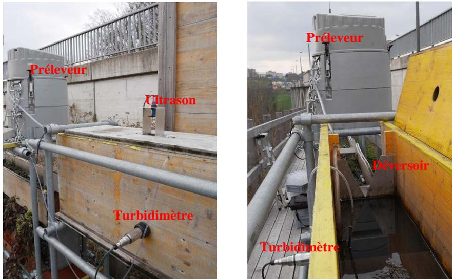
Figure 6-2 : Bac d'entrée avec le déversoir et les différents instruments de mesures installés.
