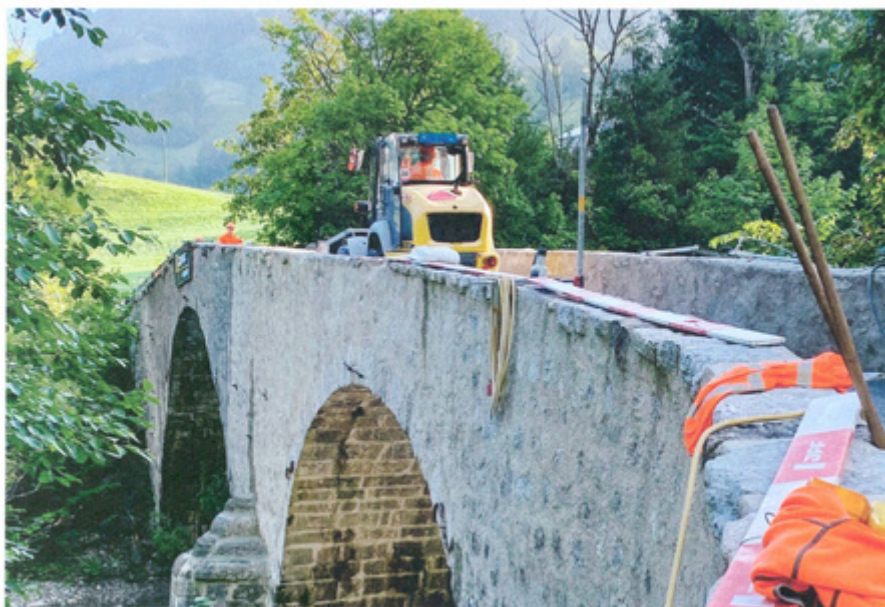
Impression du chantier (e. brühwiler)
