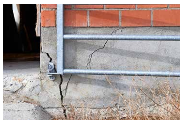
Am Hohberg geriet diesen Frühling ein Hang ins Rutschen.
